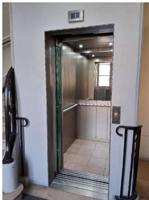
Vue de l'ascenseur depuis le palier du 1 er étage
