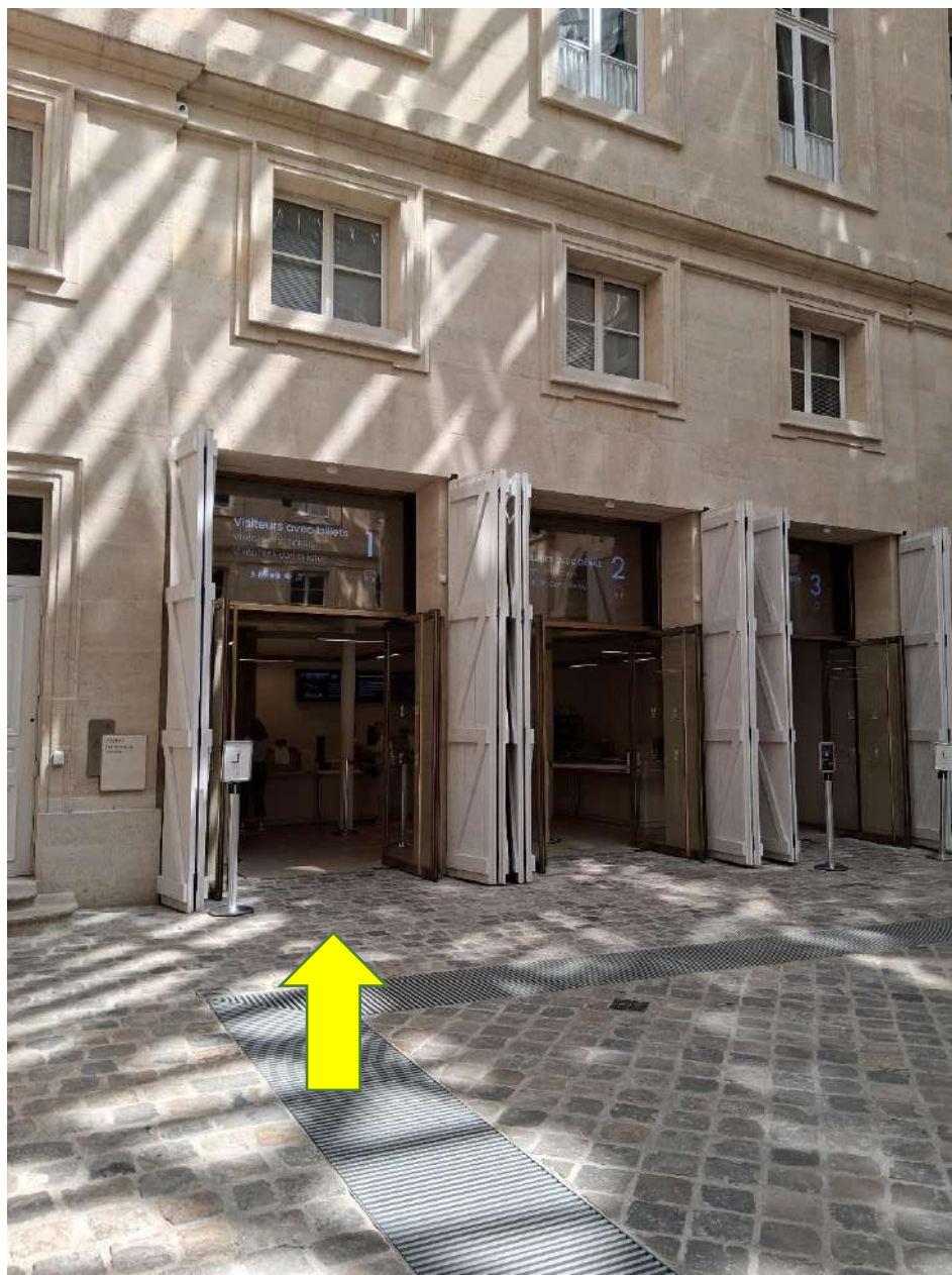
Vue de la billetterie depuis l'entrée de la cour de l'intendant
