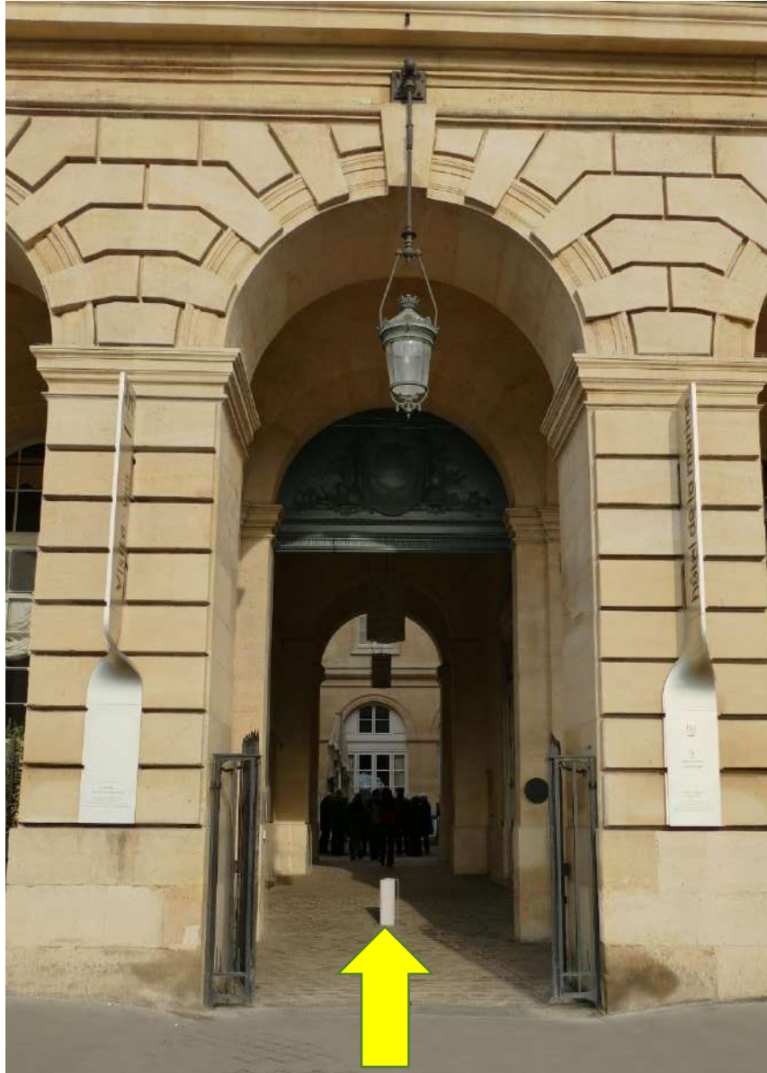
Entrée du monument devant de 2 place de la Concorde
